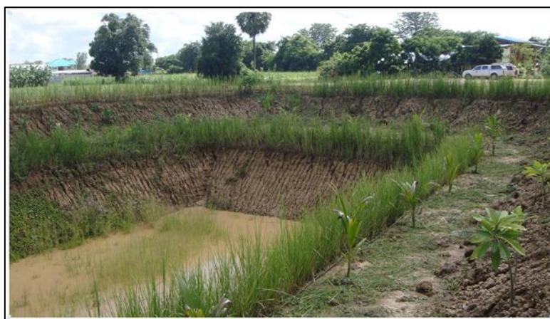
ภาพที่ 63 การปลูกหญ้าแฝกรอบขอบสระ
