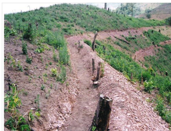
ภาพที่ 65 คันดินแบบที่ 1 คันดินเบนน้ำ
